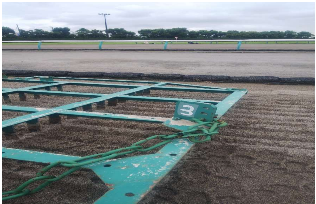
多少の腐食、歪みあり
