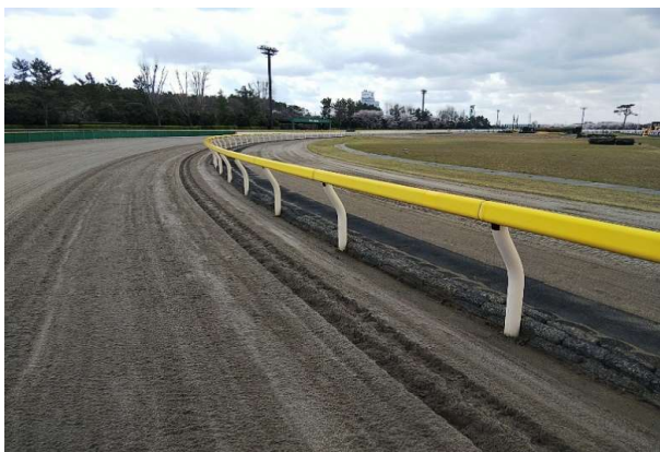
①設置時遠景(FRP製 馬場柵)
