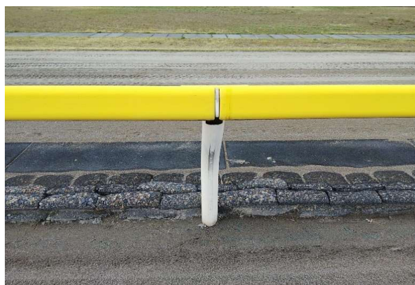
②設置時前面(経年による色落ち、汚れがあります)
