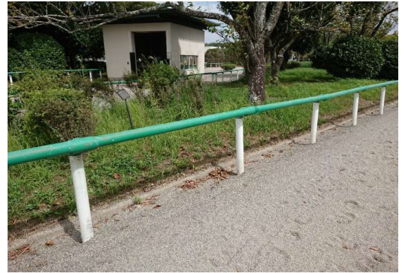
②使用状況遠景です。支柱直径は9cmで、地面に穴をあけ、地中に70cmほど埋め込んだ状態です。
