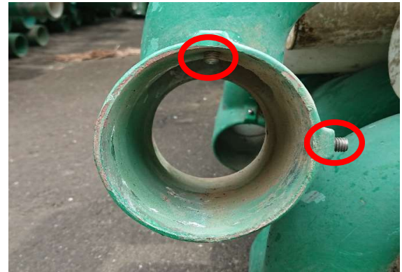
④笠木は支柱付属の六角穴付ボルト2か所で固定します。ただし、ボルトが突き出た状態で固まっているもの（笠木を通すため、ボルトの切断が必要）や、ボルトが回らなくなっているもの（笠木を固定するため、新たに別の個所に穴をあけてボルトの打ち込みが必要）が半数程度あります。
